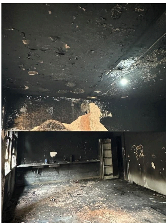
Foto 6: Testemunho retirado da viga na área afetada pelo incêndio
