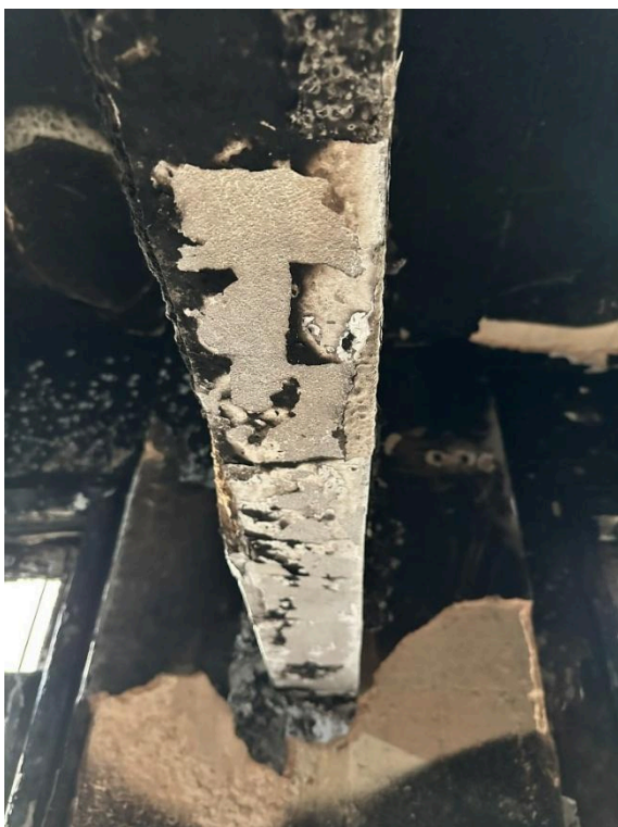
Foto 16: Fissuras na região de conexão viga-pilar
