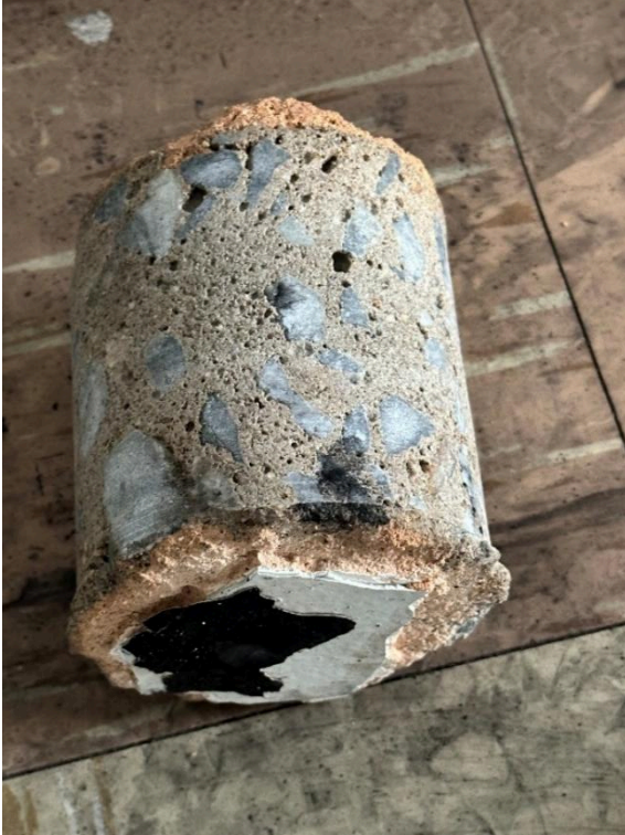
Foto 8: Testemunho retirado da laje
