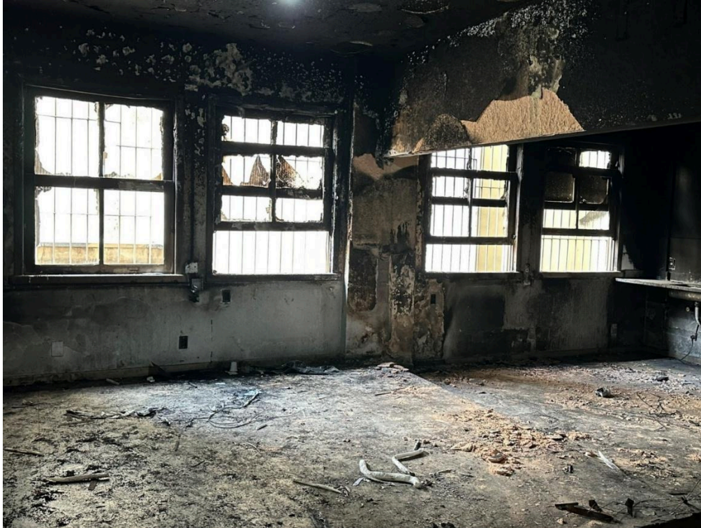
Foto 13: Vista geral da sala
