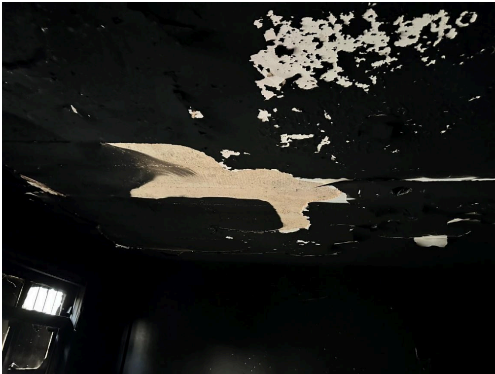
Foto 10: Deslocamento na região da laje
