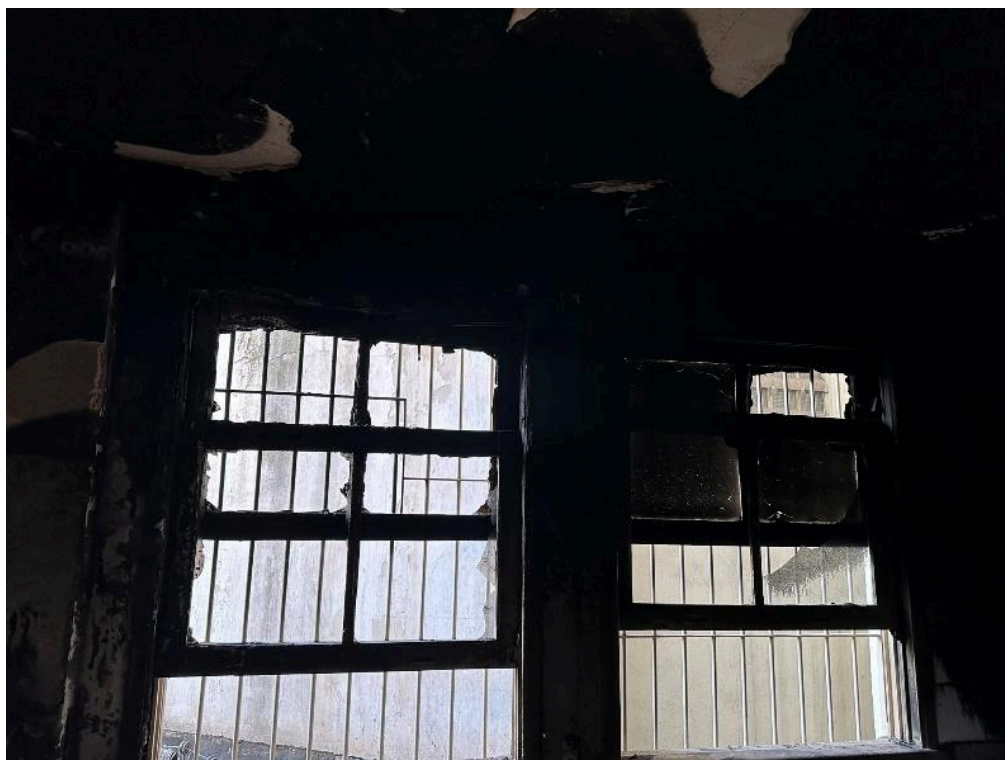
Foto 17: Vidros das janelas danificados pelo calor
