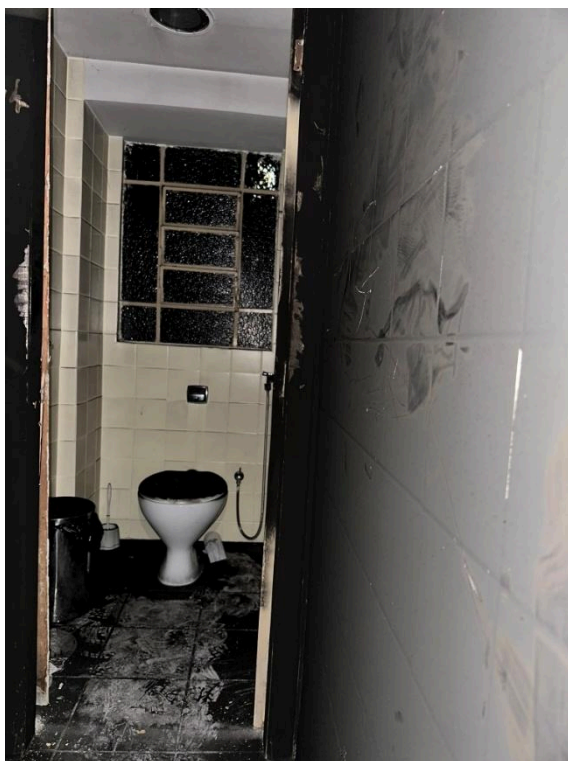
Foto 22: Revestimento do banheiro adjacente à sala não danificado
