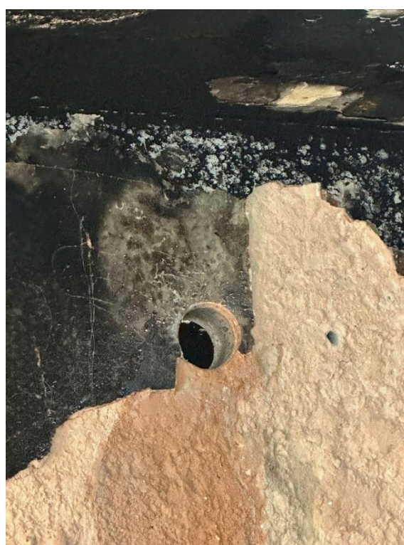
Foto 7: Testemunho retirado da viga na área afetada pelo incêndio
